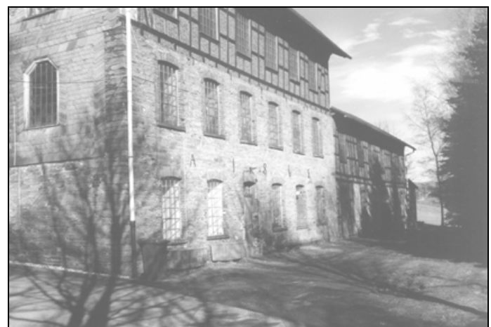
Besteckfabrik Hesse, Fleckenberg: Der Ausbau kann beginnen. Im Investitionsplan '98 wurden zusätzliche Mittel für den Dachgeschoßausbau vorgeesehen. Es könnte ein Raum für kulturelle Zwecke (z. B. für Ausstellungen, Konzerte) entstehen.
