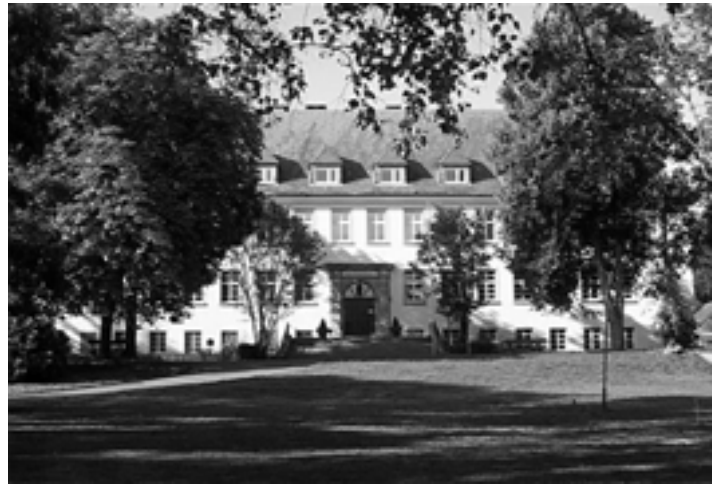
Zwar ortsbildprägend, aber stark sanierungsbedürftig
