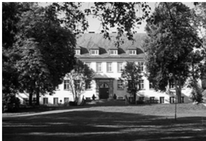
Zwar ortsbildprägend, aber stark sanierungsbedürftig
