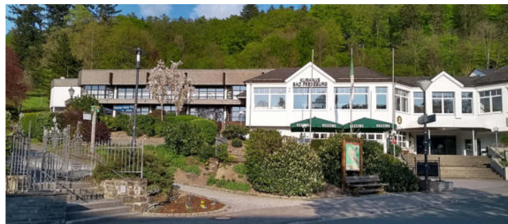
Das Kurhaus Bad Fredeburg wurde 2017/18 mit mehreren Mio. Euro komplett saniert. Die Stadthalle Schmallenberg in 2018/19.
