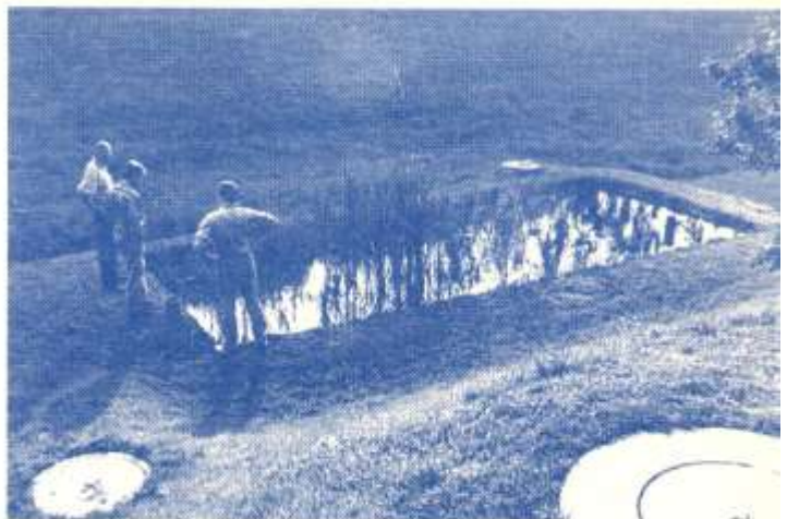
Bereits in Betrieb befindliche Pflanzenkläranlage für einen Haushalt in Selmecke bei Kircharbach
